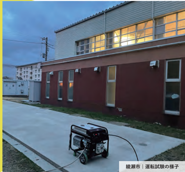
綾瀬市 | 運転試験の様子
